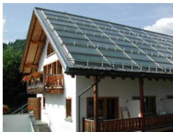
Solarkollektoren auf dem Dach des Hotel Ucliva (Bild: A. Kral, Hotel Ucliva, Waltensburg)
